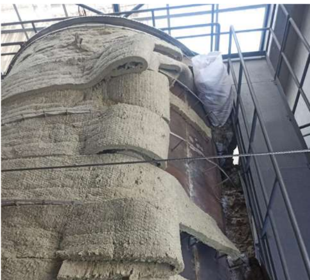
Aislamiento térmico en equipo. Flame tube.
