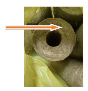
Una sola unión para evitar fugas de calor
